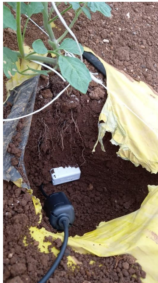
Cavi di collegamento alle sonde di umidità posta nel terreno a 15 cm di profondità
